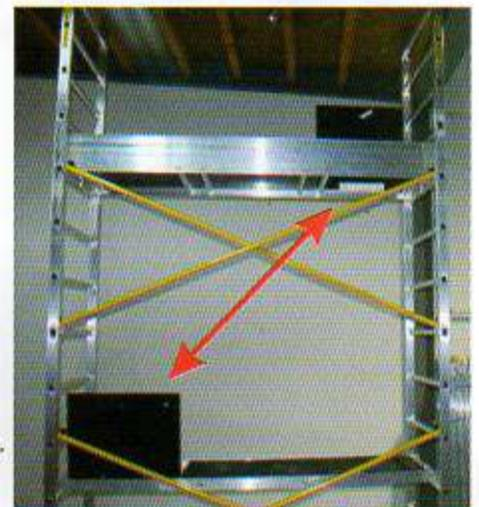
Las plataformas deberán colocarse de manera que la apertura de las trampillas NO coincidan en vertical.
